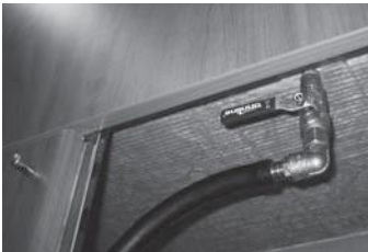
Lämpöaltaan tyhjennysventtiili
