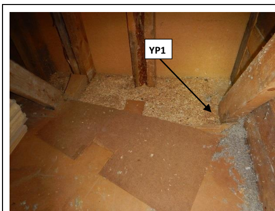
Kuva 45. Yläpohjan tarkastelupaikka YP1.
