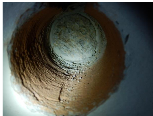
Kuva 16. Rakenneavaus MVS3, lastuvillaeriste sisäpuolen tiiliverhoilun takana.
