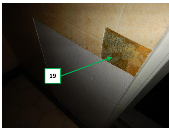
Kuva 78. Seinän muovitapetti + liima 1.krs wc:stä, näyte 19.
