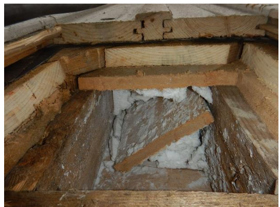
Kuva 32. Rakenneavaus US3, eristekerroksessa puukuitulevy.
