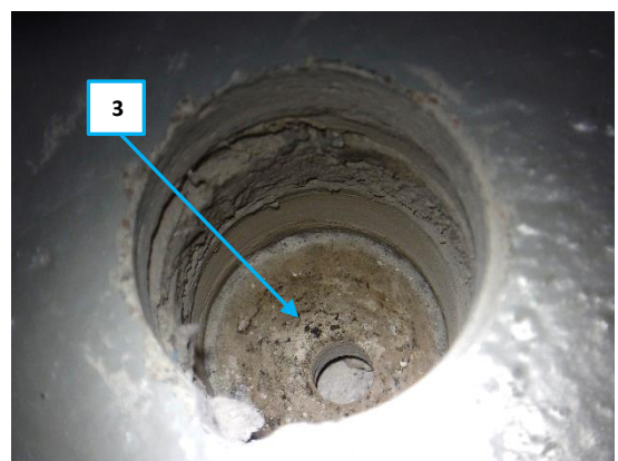
Kuva 65. Entisen kylmiön lattian rakenteet. Bituminäyte alimmaisen betonilaatan pinnalta. Näytteessä 3 ei asbestia, mutta PAH-pitoisuudet korkeat (kts, kohta 6).
