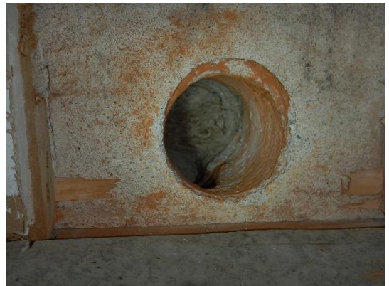
Kuva 20. Rakenneavaus MVS4, tiilikuoren takana lastuvillaeriste.
