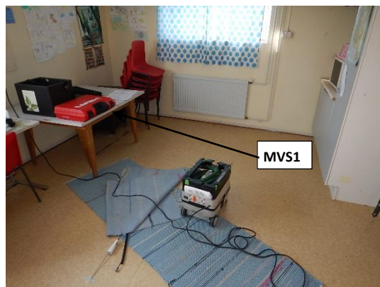
Kuva 11. Askarteluhuone, maanvastaisen seinän avauskohta MVS1.
