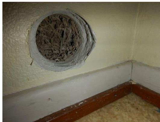
Kuva 12. Rakenneavaus MVS1, lastuvilla rappauksen takana.
