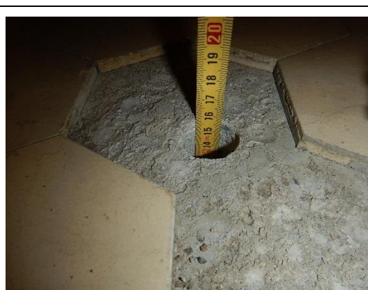
Kuva 40. Rakenneavaus VP2. Klinkkerin alla betonia n. 15 cm sen alla muottilauta ja eristetila
