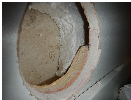
Kuva 14. Rakenneavaus MVS2, seinän sisäpintaan on tehty lisäeristys styroxilla.
