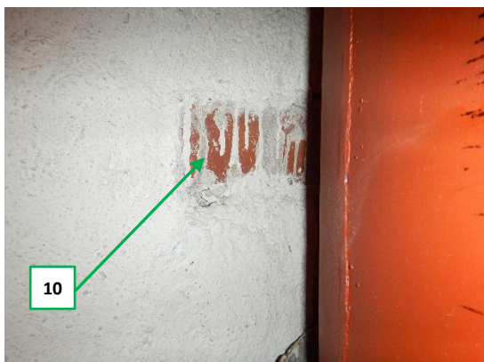
Kuva 70. Ullakkokerroksen vesisäiliöhuone. Hormin maalia ja rappausta koontinäytteeseen 10.
