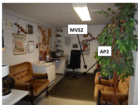
Kuva 13. Taukotila, rakenneavauspaikat AP2 ja MVS2.
