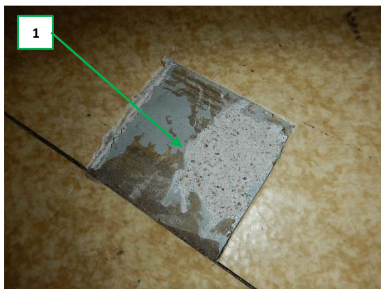
Kuva 64. Askarteluhuoneen lattia, näytteen 1 otto-kohta.
