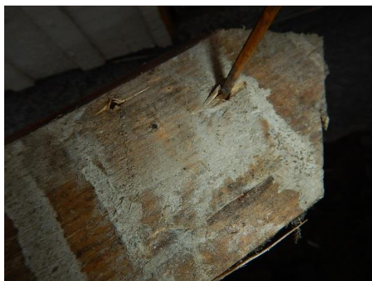
Kuva 23. Rakenneavaus US1, vinolaudan sisäpin-taa, pilkkumaista kasvustoa
