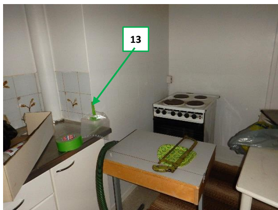
Kuva 72. Näyte 13 kellarikerroksen asunnon keittiön vanhasta laatoituksesta. Samanlaisia laatoituksia on myös 1.kerroksessa.
