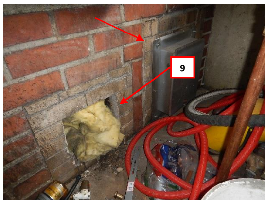
Kuva 57. Tulitiiliimuurauksia kattilahuoneessa, näytteenottoa
