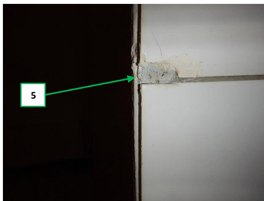
Kuva 66. Näyte 5, pesuhuoneen seinän keraaminen laatta + laastit.
