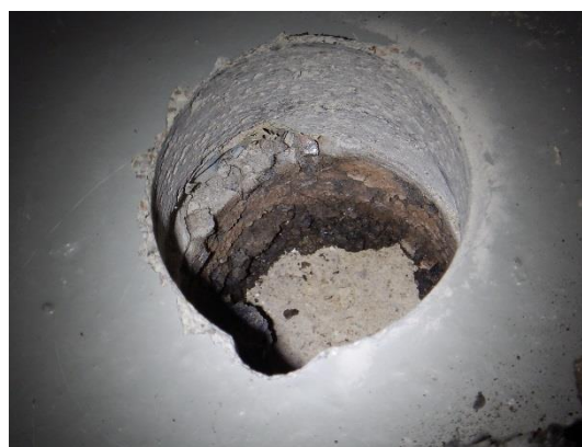
Kuva 4. Rakenneavaus AP2, korkkieriste pinta-betonilaatan alla. Alapohjan bitumi on kuvassa reiän pohjalla näkyvän betonilaatan alla.
