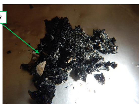
Kuva 69. Asunnon lattiasta otettu bituminäyte, vaikutti samantyyppiseltä kuin pesuhuoneesta otettu.
