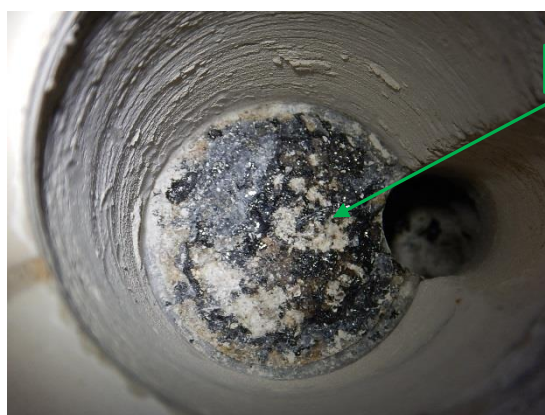
Kuva 68. Pesuhuoneen alapohjan bitumieristys. Näytteeseen 7 otettiin materiaalia myös asunnon lattiasta.
