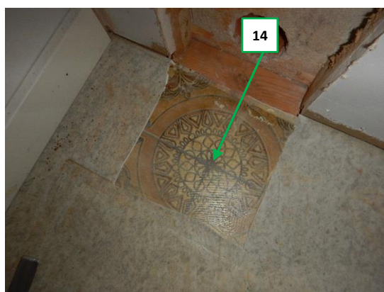
Kuva 73. Kellarin asunnon oh. Vanha kuvioitu muovimatto uudemman alla, näyte 14.
