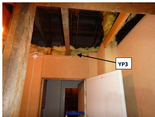
Kuva 49. YP3 eteisaulan kohdalla katon eristeenä lasivillaa
