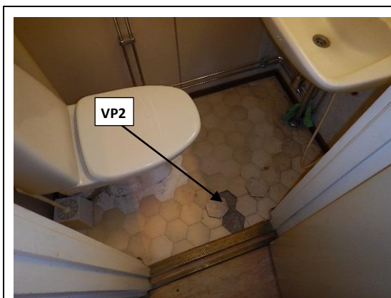
Kuva 39. Rakenneavauspaikka VP2 wc:ssä.
