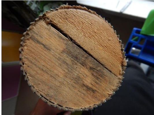
Kuva 25. Rakenneavaus US2. Sisäpuolen laudoituksen pinnalla tummentumia.
