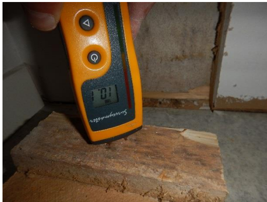
Kuva 19. Rakenneavaus MVS4, lauta oli tarkastushetkellä kuiva.
