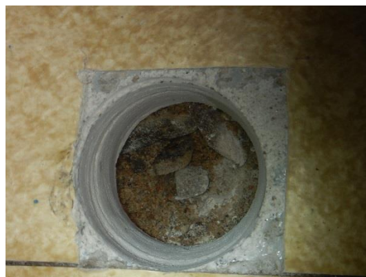
Kuva 2. Rakenneavaus AP1, ei lämmöneristettä. Näyte 1, lattian matto + liima + tasoite + maalia.
