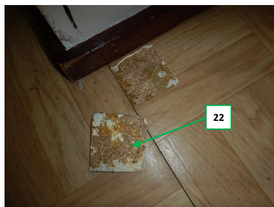
Kuva 81. Näyte 22, ullakkokerroksen asunnon puukuviainen muovimatto + liima.
