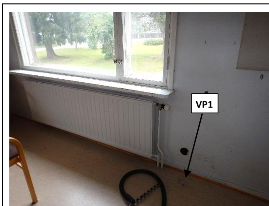
Kuva 37. Välipohjarakeneen tarkastuspaikka VP1.
