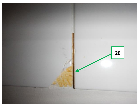
Kuva 79. Yläkerran asunnon kalustevälilaatoituksesta näyte 20, laatta + liima + sauma-aine.
