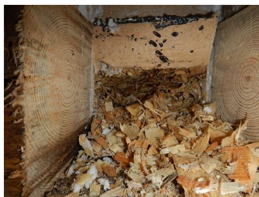
Kuva 42. Välipohjan kutterinlastusta näyte otettiin ulkokautta US3 avauksesta, ei viitettä vauriosta.
