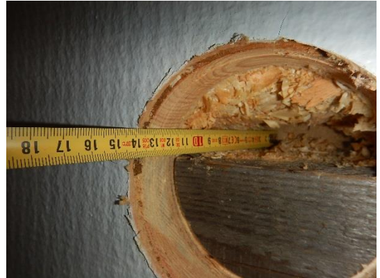
Kuva 26. Rakenneavaus US2, eristeenä kutterinlastu.
