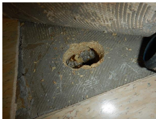
Kuva 38. Rakenneavaus VP1, yläpinnassa selluvillaa, alempana eristeenä kutterinlastu.
