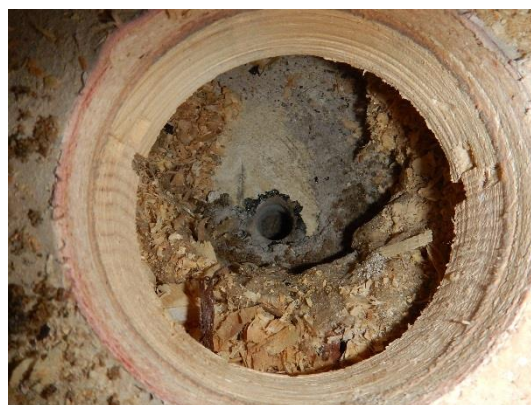
Kuva 8. Rakenneavaus AP4, maanvaraisen betonilaatan päälle koolattu puulattia, eristeenä kutterinlastua, alareunassa mineraalivillaa. Bitumi pohjabetonilaatan pinnalla
