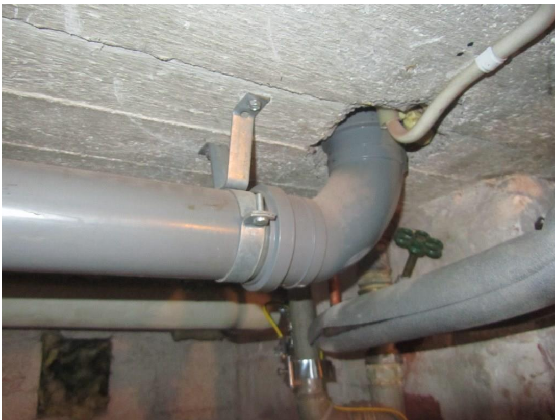
Osa viemäriputkista on uusittu.
