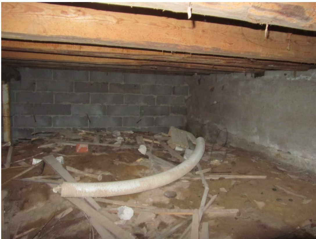
Laajennusosan harkkoseinää. Alapohjatiljan siivoaminen ylimääräisistä materiaaleista.
