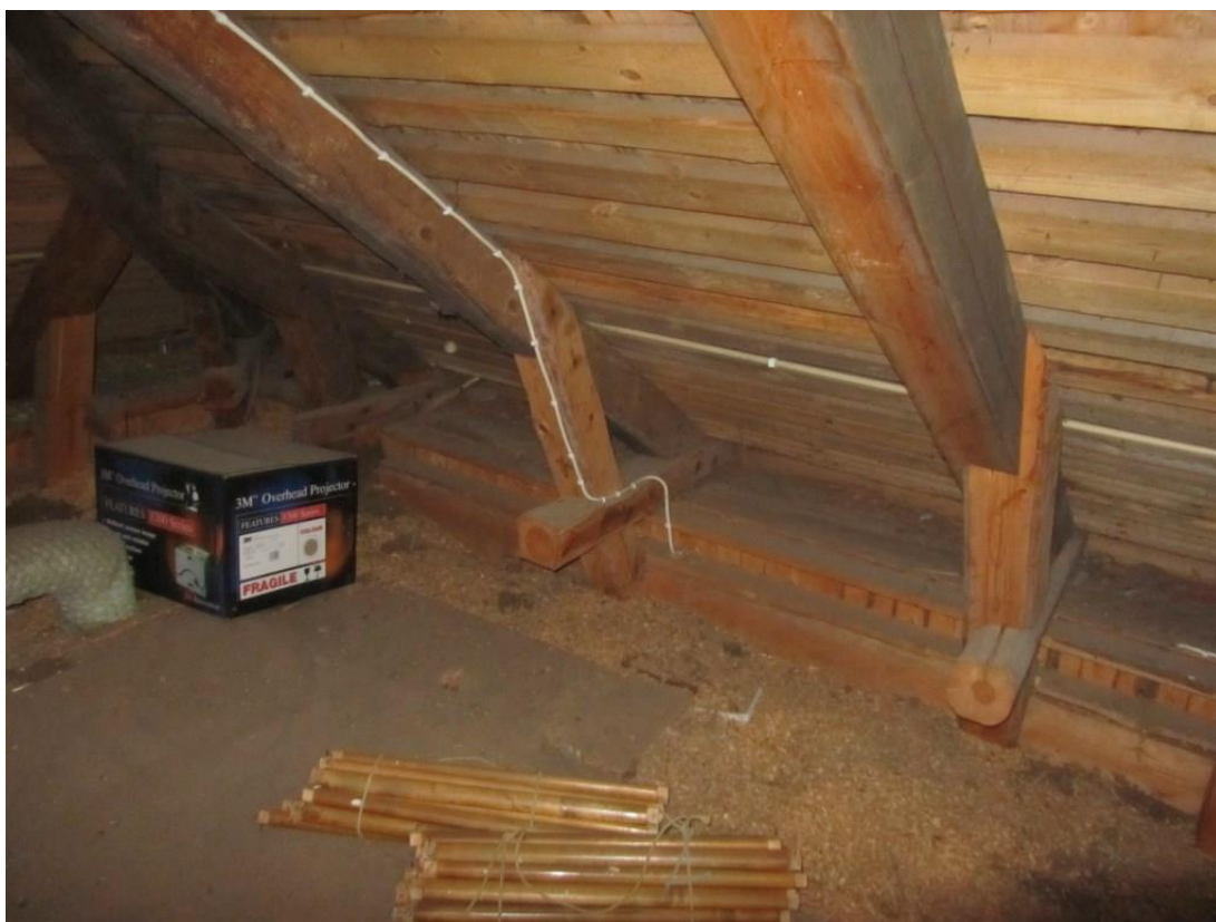
Kuva yläpohjasta, sivuilla umpiräystäät.
