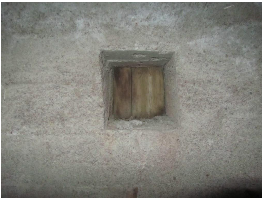
Tuuletusluukku tukittuna.
