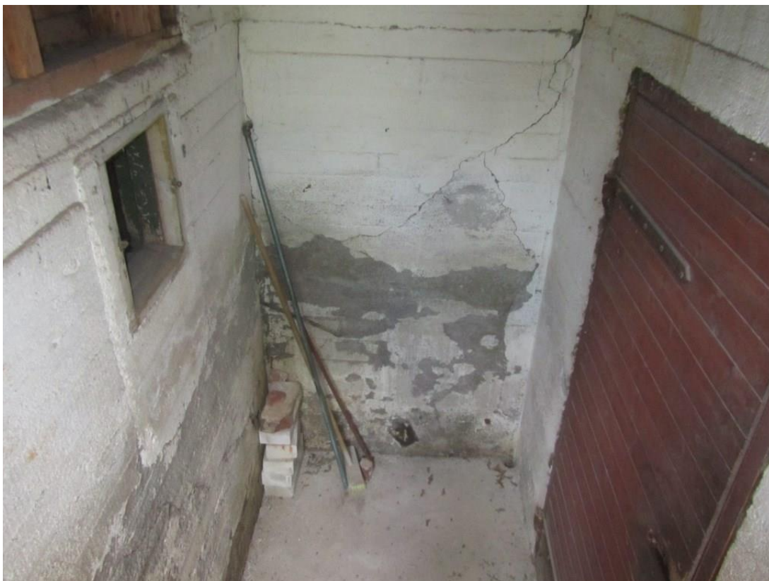
Vanhan osan kellarin rappukäytävä.
