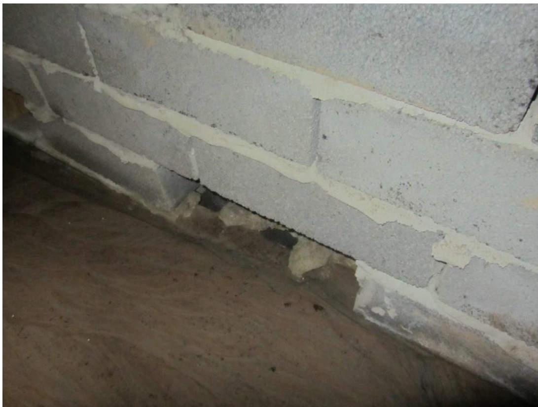
Kaivannon pohjalla vesimärkää hiekkaa.
