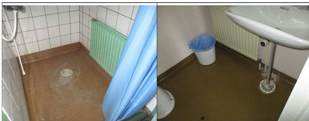
Erillis-wc. Vanhoja vuotojälkiä patteritermostaatin kohdalla.
