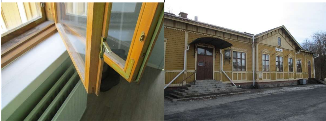
Ikkuna sisäpuolelta. Ulko- ja sisäpuitteiden väleissä kosteusjälkiä.
