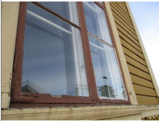
Ikkunoissa ei vesipellityksiä. Ulkopuitteet huonokuntoiset.
