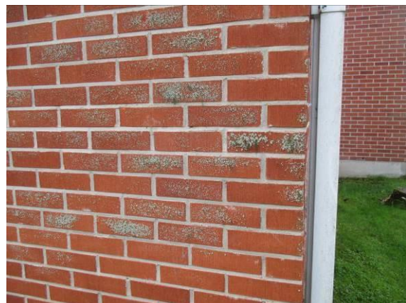
Kuva 6. Ulkoverhouksissa jäkälää
