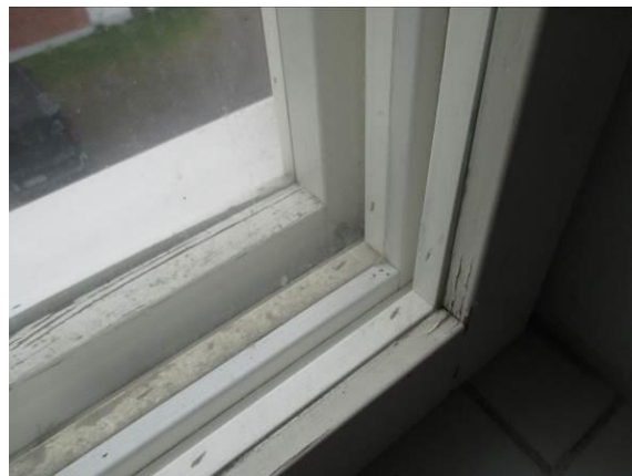
Kuva 36. Osassa asunnoista on 3-puitteiset ja 3-lasiset MSK-puuikkunat
