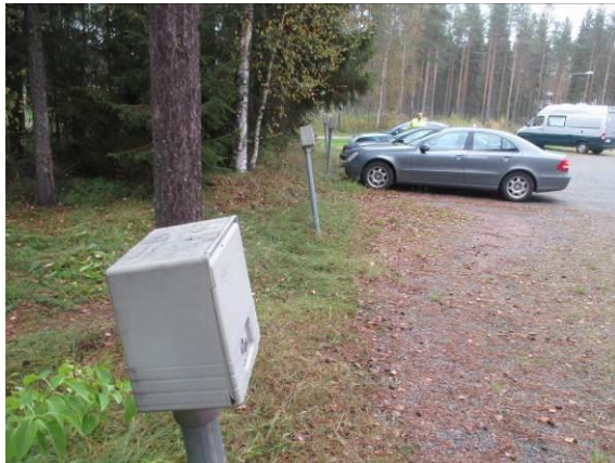
Kuva 43. Lämmitystolpat ovat vinossa
