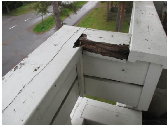
Kuva 10. Parvekkeiden kaiteissa lahovaurioita
