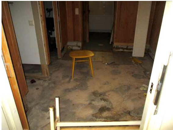
Kuva 25. A-B-talon saunatilat purettu osittain ja poistettu käytöstä
