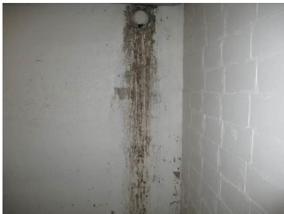
Kuva 29. A-B-talon häkkivarastoon tulee sadevettä korvausilmaputken läpiviennistä
