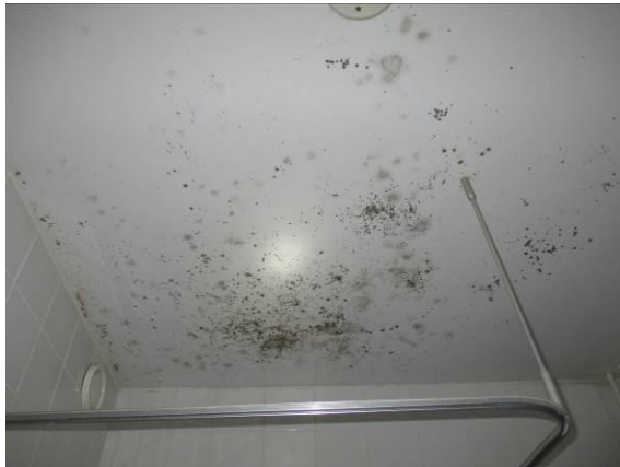
Kuva 37. Pesuhuoneiden katoissa havaittiin ilmanvaihdon puutteeseen viittaavaa pintahometta
