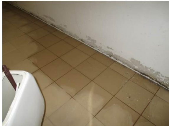
Kuva 20. Kellaritiloissa irtovettä
