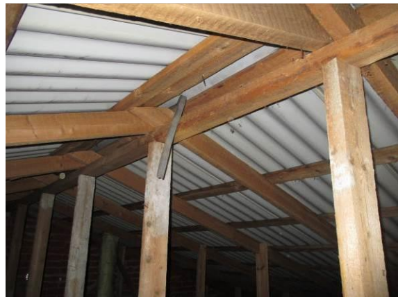
Kuva 16. Peltikatteen alla ei aluskatetta
