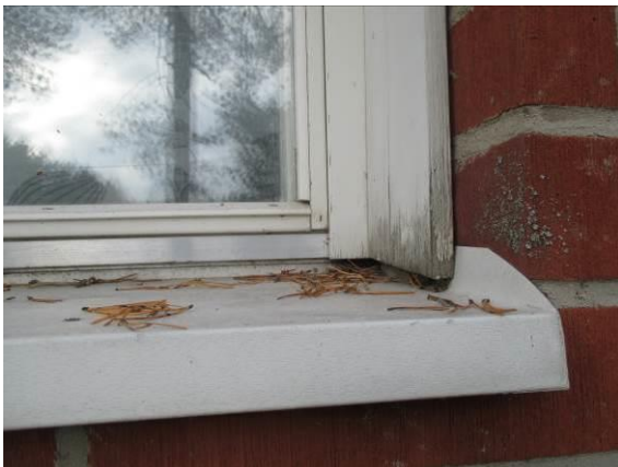
Kuva 11. Ikkunapeltien kaato vaatimaton
