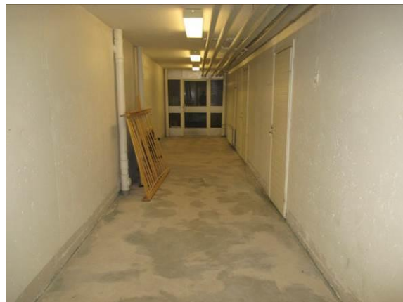
Kuva 22. Kellaritiloissa lattiapinnoitteet purettu
