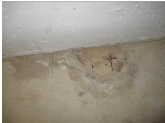
Kuva 28. Häkkivaraston lattiassa kosteusvaurioita
