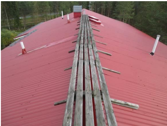
Kuva 13. Kattosillat huonokuntoiset
