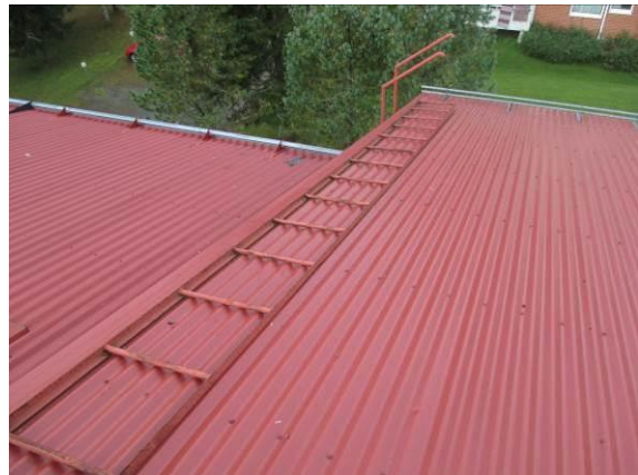
Kuva 14. Lapetikkaat huonokuntoiset
