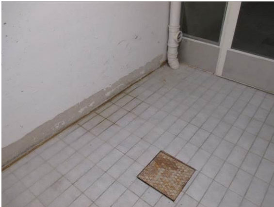
Kuva 19. Kellarin lattiassa runsaasti kosteutta
