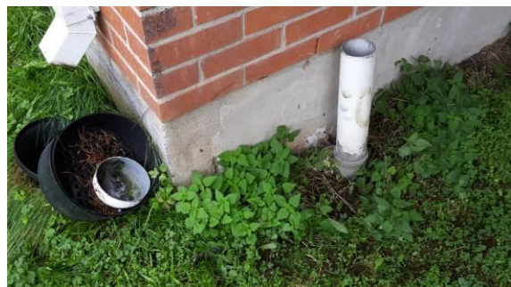
Kuva 30. Korvausilmaputken vieressä syöksytorvi ja rännikaivo
