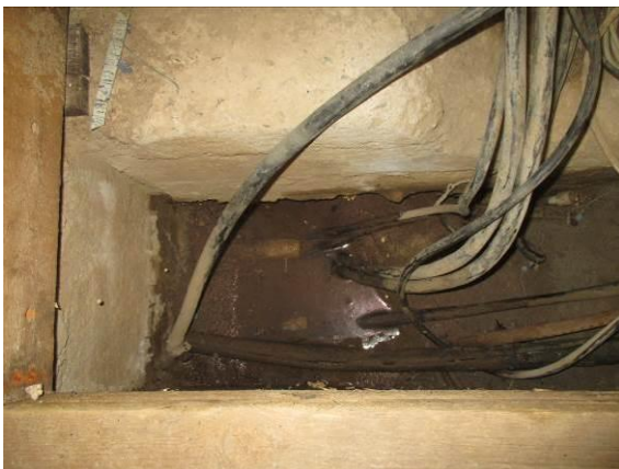
Kuva 23. Sähköpääkeskuksen putkikanaalissa havaittiin pohjavettä
