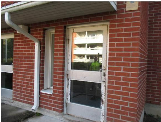
Kuva 3. Ulko-ovien maalipinnat kuluneet
