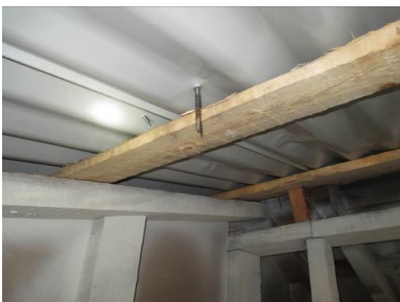
Kuva 17. Vesikatteessa havaittiin runsaasti ruuvien reikiä
