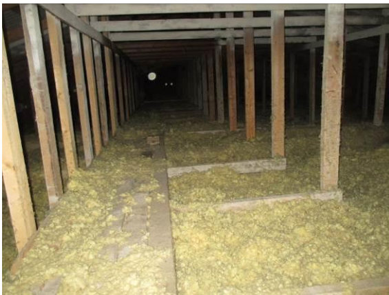
Kuva 15. Yläpohjan eristetilaa
