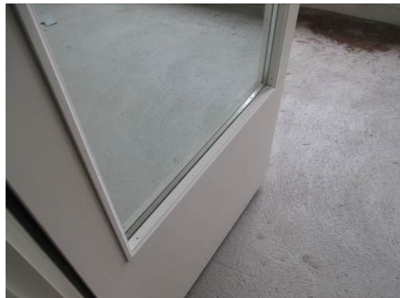
Kuva 40. Osaan asunnoista parvekeovet on uusittu yksilehtisiksi
