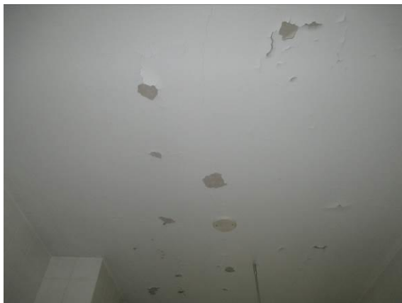
Kuva 41. Pesuhuoneiden katoissa havaittiin kosteuden aiheuttamaa maalin irtoamista
