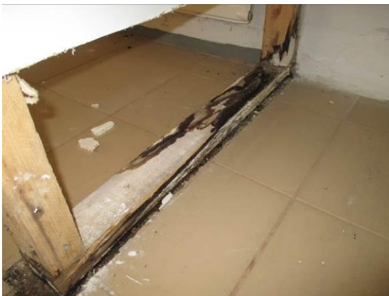
Kuva 21. Kellarin väliseinissä puuosissa kosteusvaurioita
