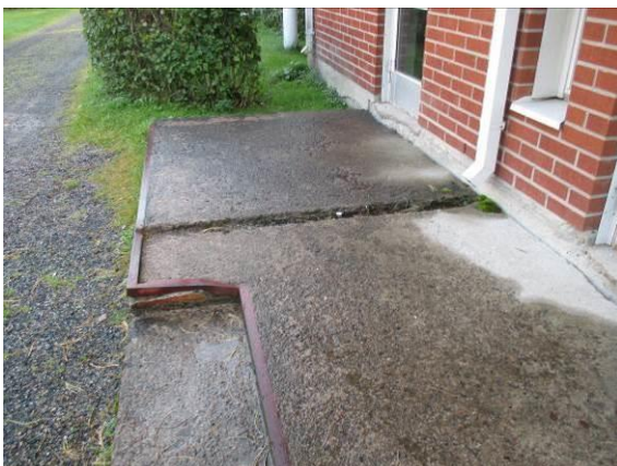
Kuva 5. Porraslaatat huonokuntoiset ja painuneet
