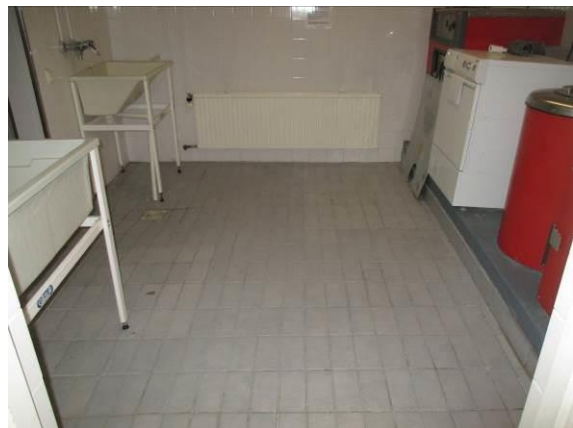
Kuva 24. Talopesulan lattiassa havaittiin alustaan irti olevia laattoja
