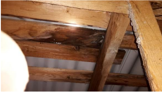
Kuva 31. C-D-talon vesikatteessa vuotoja
