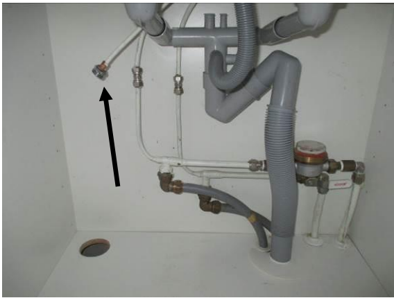
Kuva 33. Allaskaapeissa tulppaamattomia astianpesukoneen liitäntöjä
