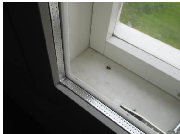
Kuva 42. Osaan asunnoista ikkunat on vaihdettu MSE-puuikkunoiksi
