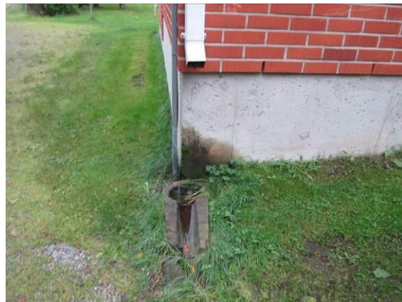
Kuva 8. Syöksytorni liian korkealla
