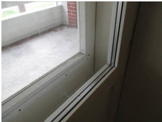
Kuva 39. Osassa asunnoista parvekeovet ovat kaksilehtisiä
