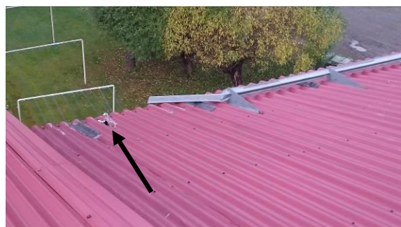
Kuva 18. B-päädysssä lumiesteitä irronnut ja vesikatteessa reikä
