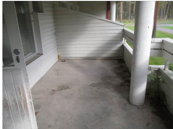
Kuva 38. Parvekkeiden betonirakenteet hyväkuntoisia
